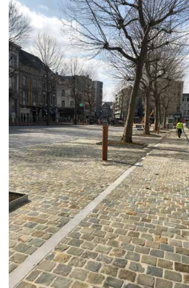
GBA a d'abord livré ses pavés en grès au format 15x15 pour la place du Marché, puis ont suivi la place Verte et les trottoirs de l'axe Crapaurue.
